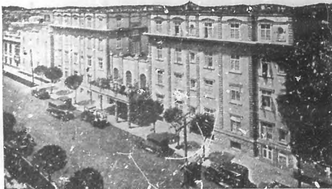
PACHADA DEL HOTEL
